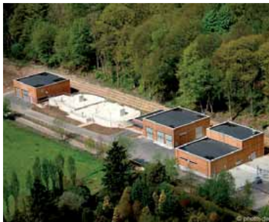
Station d'épuration, 13 000 EH (Louvain-la-Neuve, Belgique)
