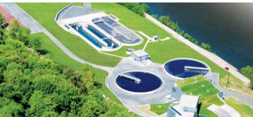
Station d'épuration, 93 100 EH (Namur, Belgique)
